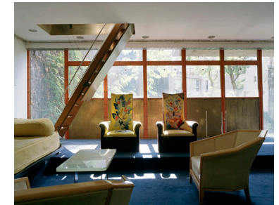
Escalier escamotable menant à un appartement
